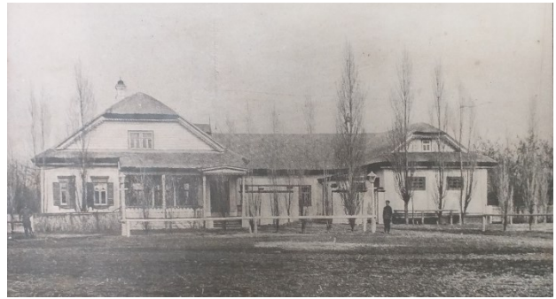
Рис. 2. Будинок керуючого заводом і аукціонна зала
