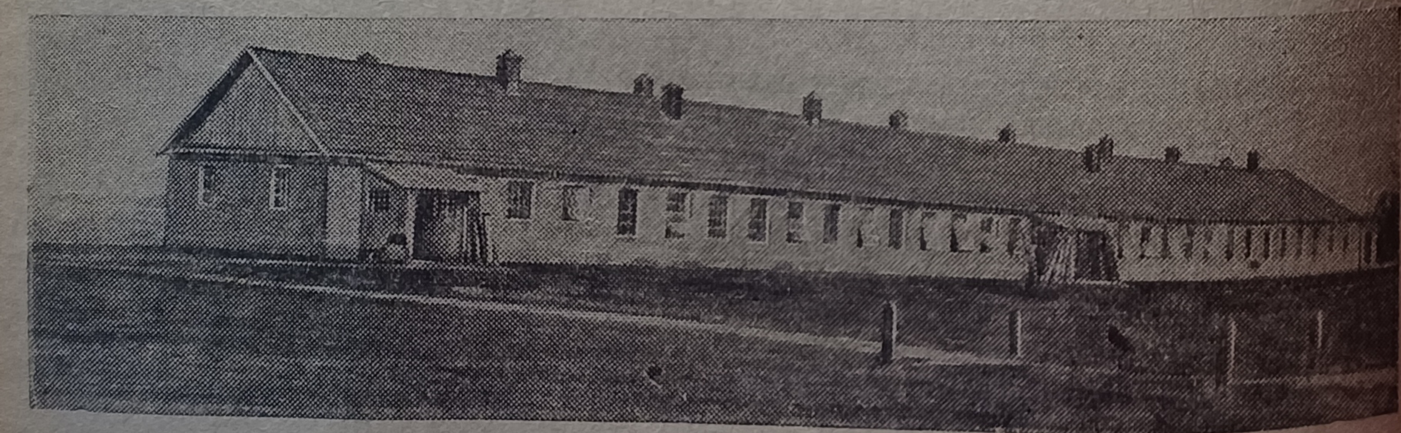
Свинарник системы проф. Левитского, построенный на ферме института свиноводства. В этом свинарнике проходы сделаны вдоль стен, что позволило значительно увеличить окна и одновременно предохранить поросят от простуды
